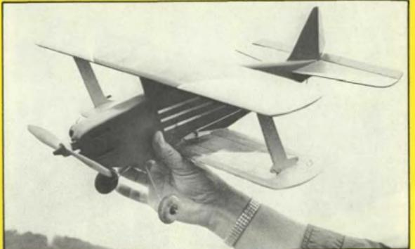
▲ Na sovětský motor Stryž postavil Ing. Rudolf Laboutka z Prahy ze stavebnice firmy MOBA zakoupené v NDR celobalsový upoutaný dvouplošník Kadett o rozpětí 600 mm
