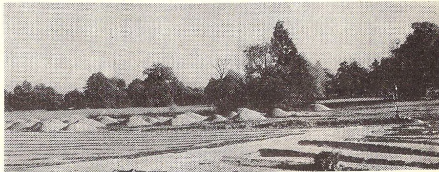
Rozestavená RC dráha (za černobílými tyčkami) loni na podzim. V pravé části již rozhrnutý, v levé navezený štěrk
