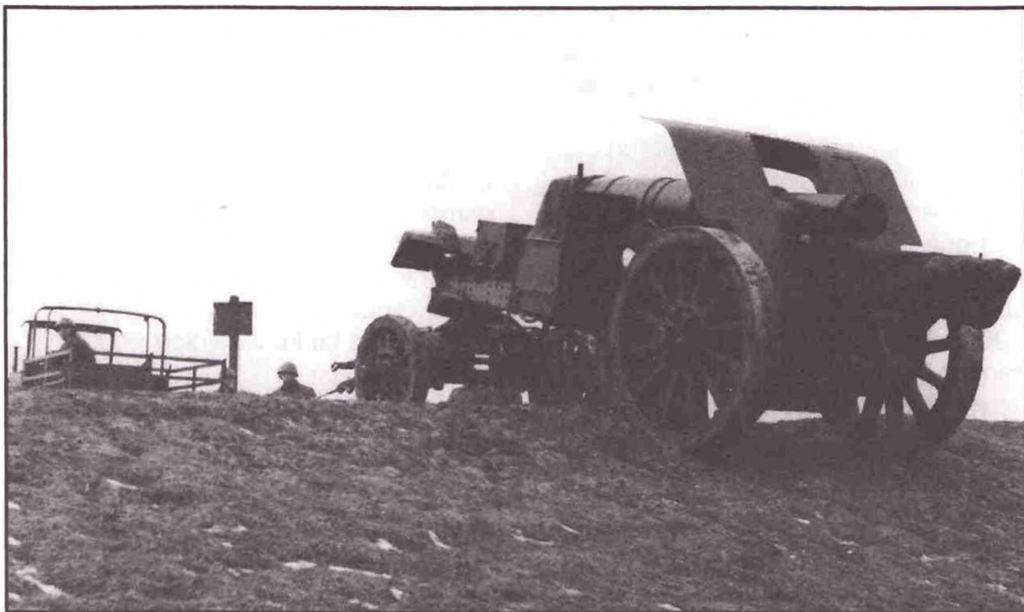
Těžká houfnice vz. 15 v dopravní poloze, spodní část lafety je uložena na kolesně.
