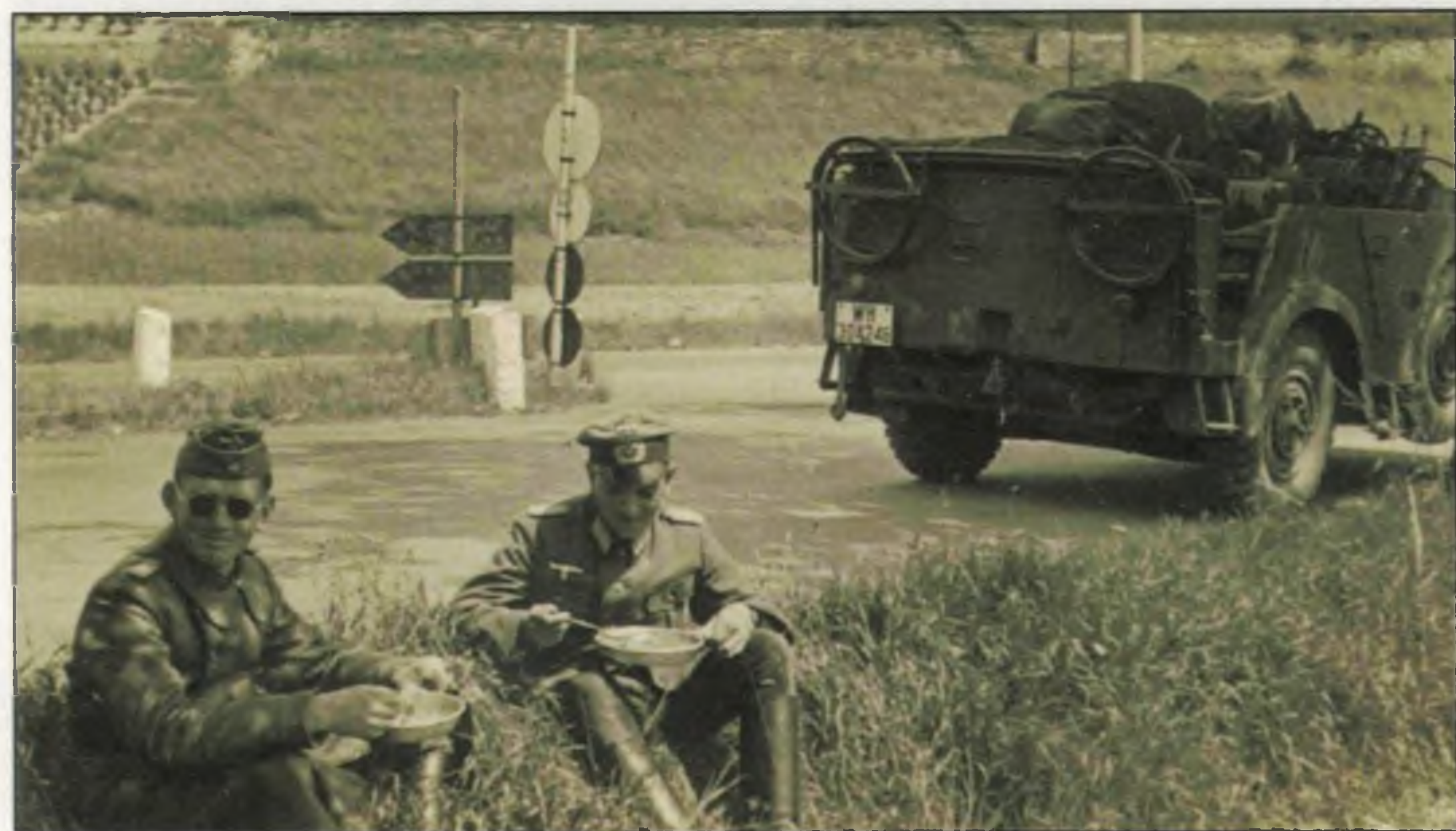
Raritní fotografie málo vidané konverze schwere gelände Einheits-Personenkraftwagen 4x4 Horch 108. Všimněte si třetích dveří za zadním kolem a spojařského vybavení
