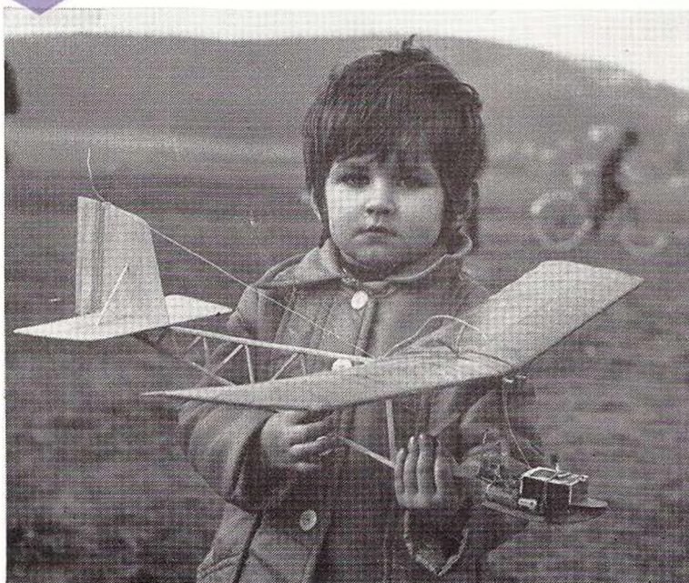
Polomaketa školního kluzáku je prací Fr. Štěrbačka z LMK Brno-střed. Rozpětí je 600 mm, délka 520 mm, plošné zatížení 14 g/dm 2 , radio Brand Hobby (2 tužkové baterie) řídí směrovku pomocí magnetu
