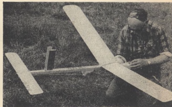
BĚLÁSEK – u nás první svahový větroň s tzv. zadním řízením postavený J. Karáskem z LMK Žamberk – při premiéře na Raně
