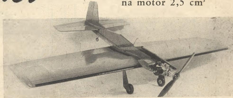
Polomaketa Mustang s plochým trupem je jednoduchou stavbou, pevností a snadnou řiditelností určena především modelářům méně pokročilým. Se zamontovaným výkonějším motorem však může uspokojit i náročnější. Po malých úpravách pak plně využouje i podmínek modelářského souboje (combat).
