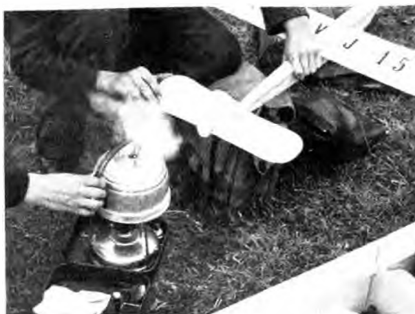
Abb. 5. Dampfanlage zum Biegen im Gelände.
