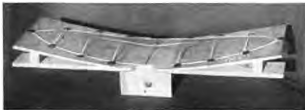
Abb. 4. Tragflügelhelling mit aufgestetztem Tragflügel.
