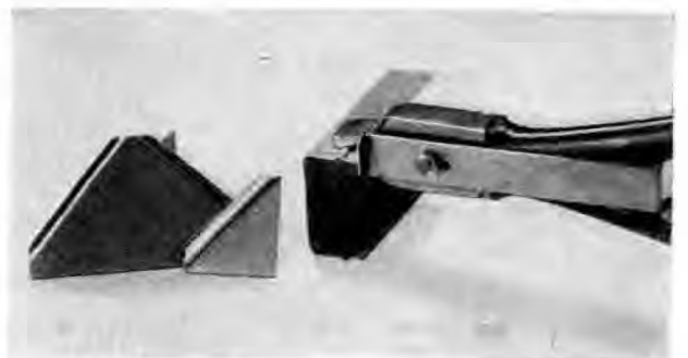
Abb. 3. Die Rillenzange erzeugt Rillen oder Sidungen.
