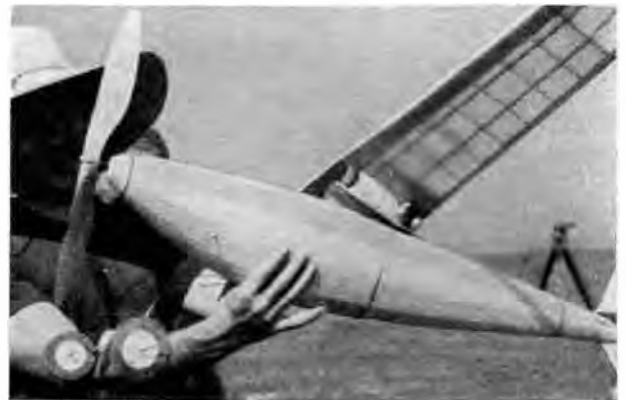
Abb. 12. Kanadische Tragflügelbefestigung.
