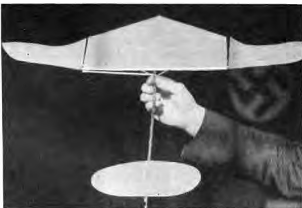
Abb. 5. Saalflugmodell des Enten-Baumusters mit Schwingen-antrieb von Pippisch.
