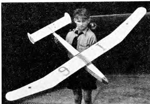
Abb. 3. Flugmodell mit ausklinkbarem Tragflügel und abnehmbarem Leitwerk
