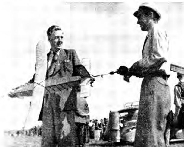
Abb. 4. Leistungs-Gummimotor-Flugmodell, dessen Gummimotor die „Krax“-Umlenkung besitzt
