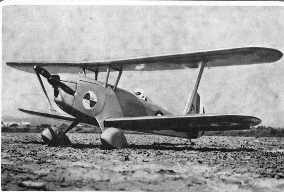
Avion d'acrobatie R/C (inspiré du Stampe) de Gilbert ALLAIN, président du MACIO (Hyères). Envergure : 1 m 40 ; Long. 1 m 25 ; Poids 3 kg 650 ; moteur Micron 45 ; Radio-Pilote 8 CX.
