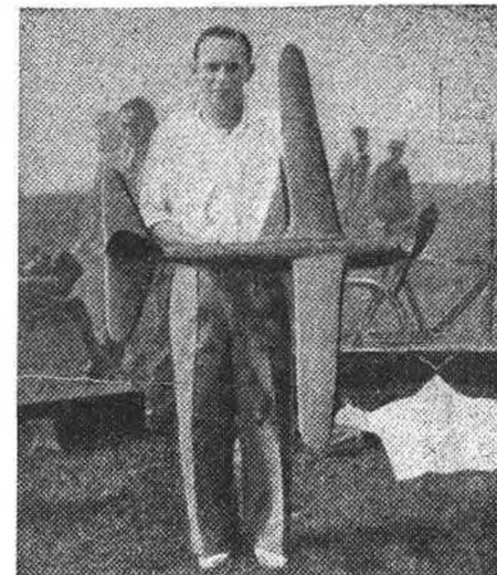
EDDIE CHASTENEUF CON SU MODELO WAKEFIELD 1938, CON EL QUE OBTUVO VUELOS DE 5 MINUTOS. COMO PUEDE VERSE, HAY PEQUEÑAS DIFERENCIAS CON LOS MODELOS ACTUALES.
