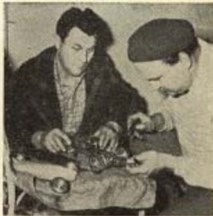
BRATŘI BOUDNÍKOVÉ z Prahy stáli u kolébků našeho automobilového modelářství. Jejich modely vynikají vypracováním, technickým řešením a často novinkami. Oba vozy na snímků jsou shodné; na demontovaném vidíte neobvyklé ležaté uložení motoru s náhonem přímo na zadní kola.
