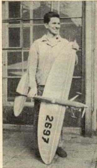
Karel Götz z MVVS Brno s akrobatickým modelem, postaveným na motor MVVS 5,6/1957. Některá data: Rozpětí 1400 mm; délka 954 mm; plocha křídla 38,2 dm<sup>2</sup>; výškotoky 7,6 dm<sup>2</sup>; celková 45,8 dm<sup>2</sup>; váha 1090 g; vrtule Ø 250/100 mm.
