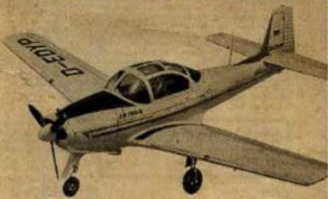
Novinkou německé firmy Graupner je maketa italského sport. letadla Piaggio PW P 149 o rozpětí 1112 mm. Létá jako R/C s motorem 2,5 ccm a tříkanálovým ovládáním.
