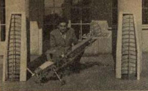
Radiem řízená maketa L-19, kterou zhotovil okresní modelářský instruktor Vladimír Lustyk z Poděbrad. Model, opatřený benzínovým motorkem Buš 8 ccm, váží bez rádia 1500 g. Tříkanálový přijímač včetně zdrojů váží 800 g. Soudruh Lustyk jej vyrabil ve spolupráci s n. p. Testa v Kolíně. Na modelu je řízena výškovka, směrovka a předstih motoru.
