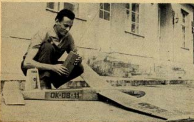
R/C vetroň T. Marcinka z Píšťan (Pionierská 92). Data: rozpětí 2470, délka 1290 mm; plocha křídla 50, výškovky 13,95 dm²; oba profily vlastní, podobné NACA 4409 (křídlo) a NACA 009 resp. G-160B (2 verze VOP); letová váha 2100 g; lpec. zatážením 30 g/dm²; rádiová aparatura MVVS; vybatovací so ltoorramennou roháthou ovláá smerové kormidlo
