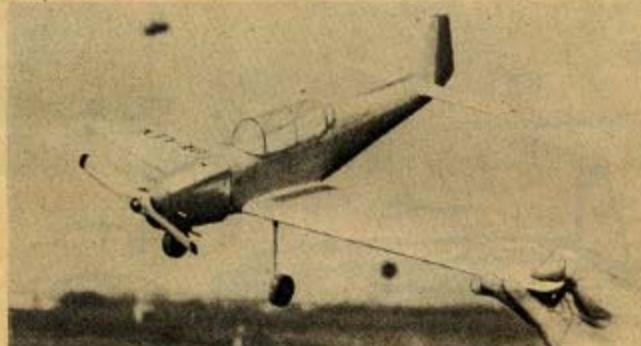
Maketu Z-226 postavil v mř. 1:16 V. Cink z LMK Škoda Plzeň. U-model z tvaré balvy vzlétí s motorem Jena 1 celkem 340 g.
