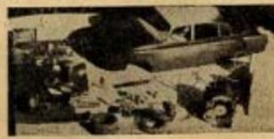
• Pro výrobu karosérie zhodnil L. Stránský nejdříve přesný model z formovací hmoty (plastelinu). Negativem tyčidlovou formu na karosérii získal zálitím modelu do sádry. Na prvním obrázku je vidět odstraňování plasteliny z odlité formy.
