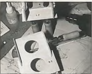
Sperrholz-Steck-Klebetchnik, die sich bewährt - mit exzellentem Vorfertigungsgrad
