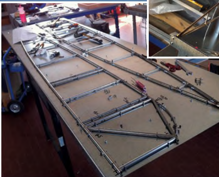
Der Rumpf wird dem Original entsprechend aus Edelstahlrohr aufgebaut.
