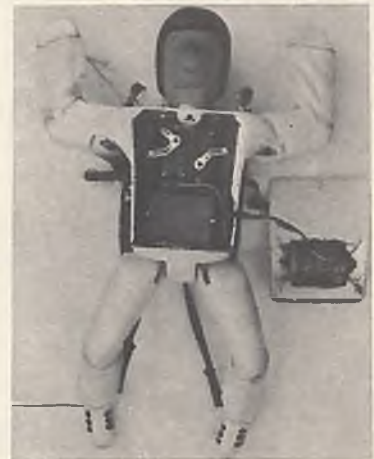
Cool Boy RC-Fallschirmspringer Konrad Riggermann, 1978, S: 1000 mm, L: 380 mm, RC: Zwei Servos zum Drehen und Vorwärtsfliegen, B: Der Fallschirm ist eine sog. Matratze, R: Holz. Best.-Nr.: MT 773 – 7,50 DM
