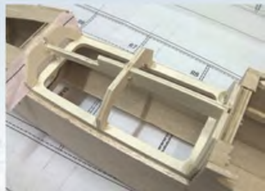
Die Kabinenhaube wird im Rumpf aufgebaut, ...
