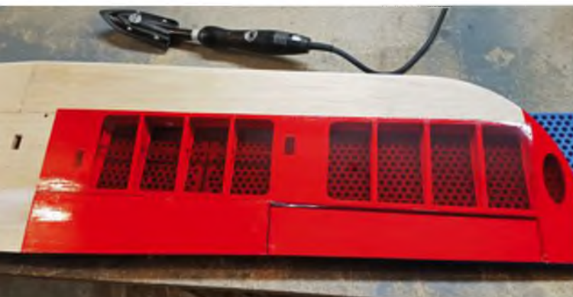
Dann folgt die obere Folienlage, die über Fläche und Ruder durchgezogen wird.
