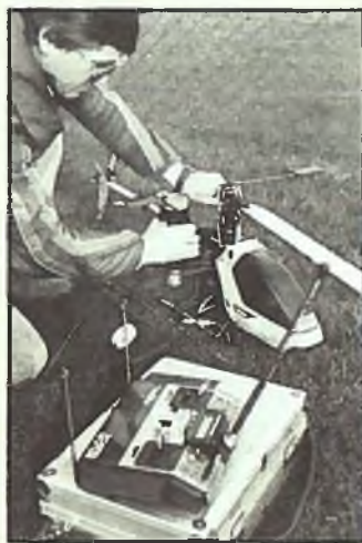
Das Anlassen mit einem Riemen mutet etwas altertümlich an, klappt aber ganz gut. Voraussetzung ist ein Anlasser mit Keilriemennut.
