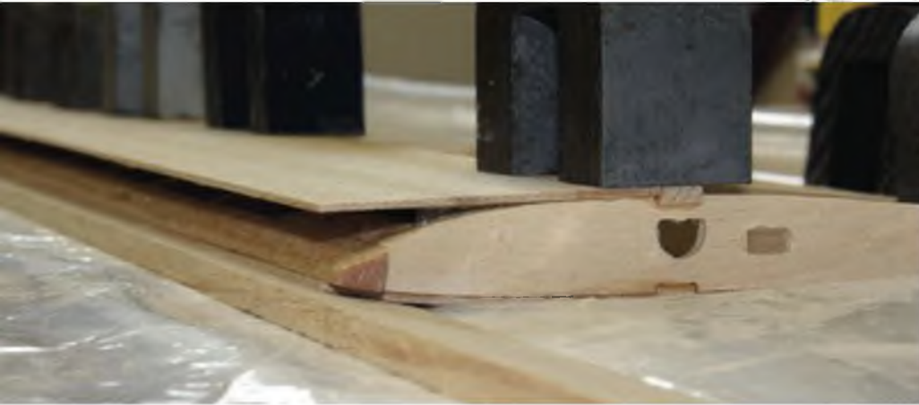
Aufziehen der Nasenbeplankung: Die Nasenleiste ist passend unterlegt, der Holm wird mit Gewichten gut angepresst. Erst wenn der Holm fest ist, drückt man die Beplankung auf die Rippen nieder (Kontaktklebung eventuell leicht anbügeln).
