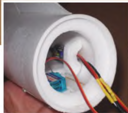
Die Kabelführung und Fixierung für den Regler.
