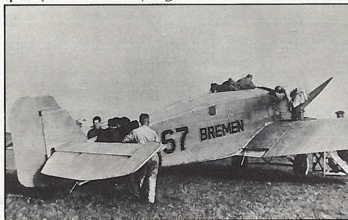
Die Flugvorbereitungen der „Bremen“. Mit der Wellblechbeplankung unverkennbar ein Junkers-Flugzeug. Hochinteressant auch die Propellerform, von der man sich einen besonders guten Wirkungsgrad versprach (Fotos Archiv Kunik, Prag)
