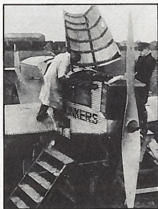
Die Flugvorbereitungen der „Bremen“. Mit der Wellblechbeplankung unverkennbar ein Junkers-Flugzeug. Hochinteressant auch die Propellerform, von der man sich einen besonders guten Wirkungsgrad versprach (Fotos Archiv Kunik, Prag)
