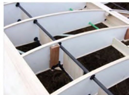
Die interessante Mischbauweise will Hugo in einem späteren Baubericht ausführlich in der FMT beschreiben.
