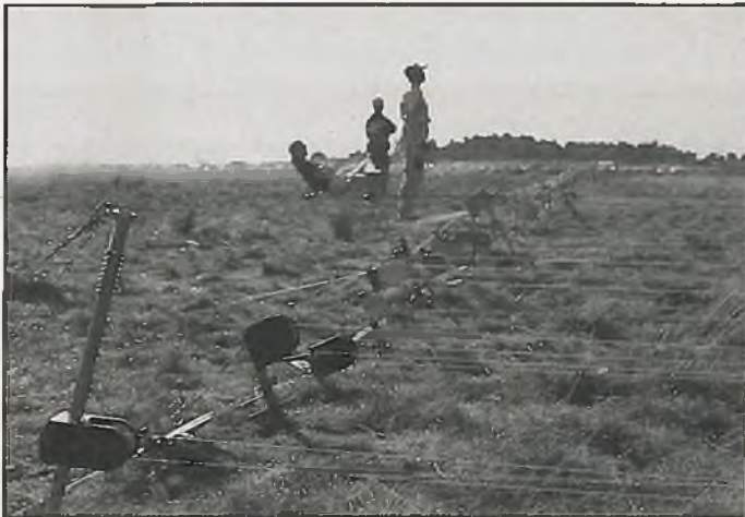
Auch die Umlenkrollen sind mittlerweile zu recht aufwendigen Geräten geworden. Vorn links eine „Fallrolle“, die beim Start auf 50 cm Höhe steigt
