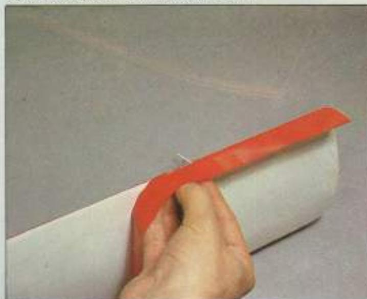
12 El sobrante del borde de salida se corta a ras, y se repasa de nuevo con la plancha para ajustar.
