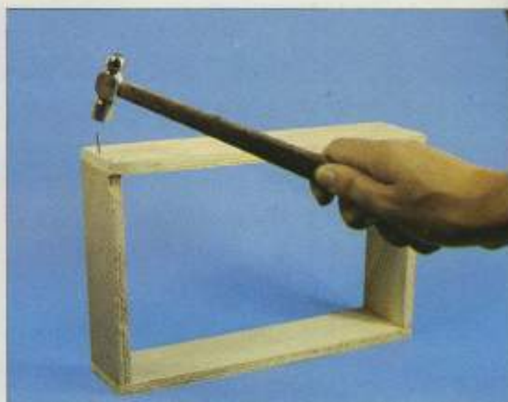
8. Confeccionar el cajón con el mismo procedimiento que el resto de la caja, es decir, cola y clavos. Verificar la escuadra.
