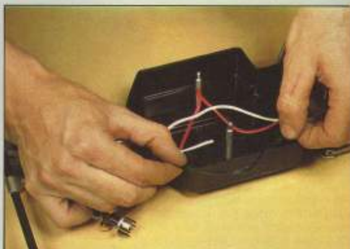
2. Los cables del motor se introducen por el taladro que previamente se había protegido con el pasamuros.
