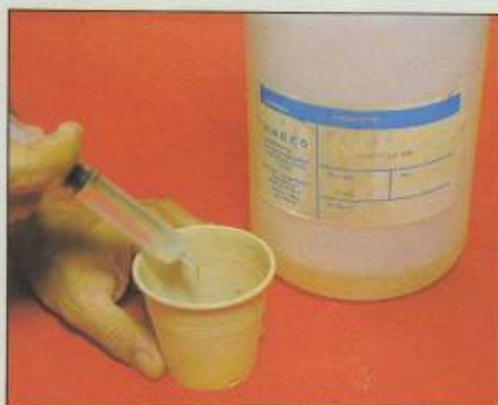
13. Hacer la mezcla de resina epóxica, siguiendo también las indicaciones del fabricante en cuanto a la proporción exacta.
