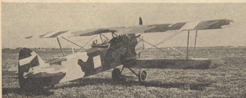
Obr. 9. Standardní kamufláž čs. vojenských letadel v letech 1923—26. Nepravidelné skvrny v barvě hnědé, okrové a zelené, každé pole o stejné sytosti barvy. Zespu všechny plochy stříbrné. Na obrázku tovární záběr letounu Aero A-11. Bílý obdélník po obou stranách trupu je pro znak jednoho ze tří leteckých pluků, podle zařazení letounu (podle obr. 6, 7, 8)
