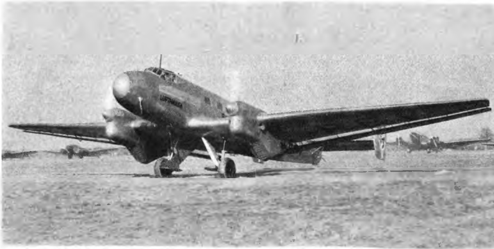
Abb. 1. Junkers Ju 86 mit 2 \times 500/560 PS Junkers Jumo 205 c.
