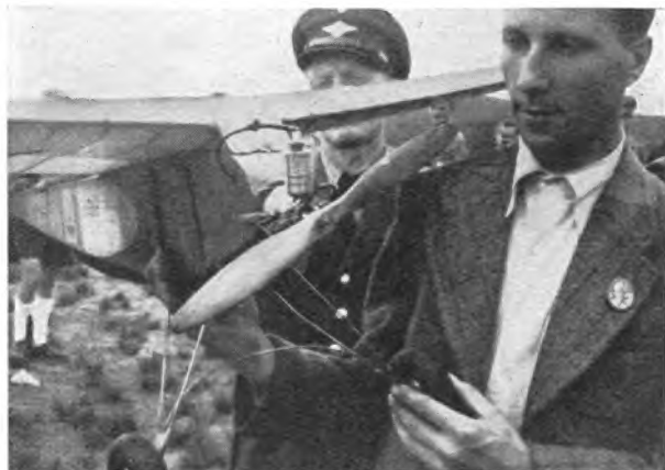
Abb. 10. Benzinmotor von Klose am Flugmodell von Lippmann.
