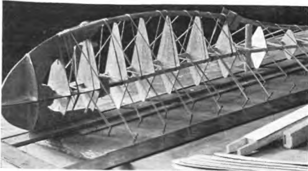
Abb. 4. Spantenrumpf auf ebener Bauunterlage.
