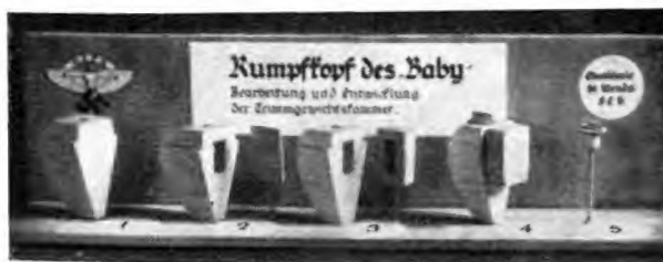
Abb. 4. Verschiedene Arbeitsstufen des geänderten Rumpfkopfes.
