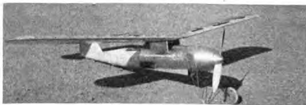
Abb. 1. Das Dampfturbinen-Flugmodell von Scholl, Pforzheim.
