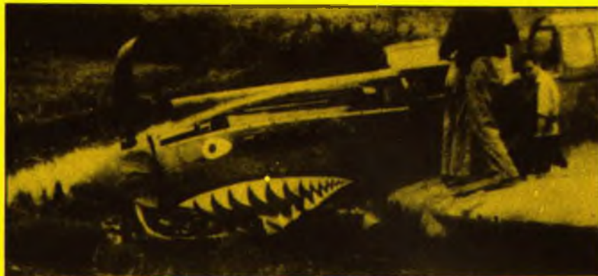
Ένα P-40 τ'ο οποίο υποχρεώθηκε σέ ανώμαλη προσγείωση, ενώ υπόκειται σέ αφαίρεση των πολυβόλων του από όπλουργούς τής AVG.
